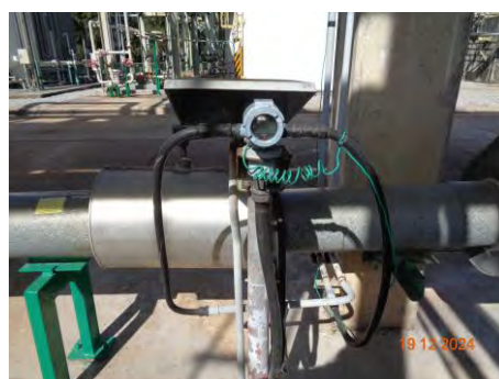
ภาพที่ 2.2-21ข ระบบ Flow Meter
