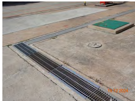
ภาพที่ 2.2-26x รางระบายน้ำฝนปนเปื้อนภายในโรงงาน
