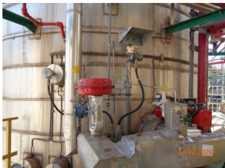
ภาพที่ 2.2-53ข Shut Down Valve และ Safety Valve
