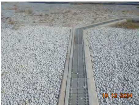
ภาพที่ 2.2-26x รางระบายน้ำฝนปนเปื้อนภายในโรงงาน
