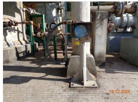
ภาพที่ 2.2-52ข Gas Detector
